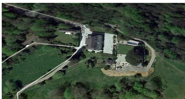
Vue aérienne sur les installations du château de Langladure
