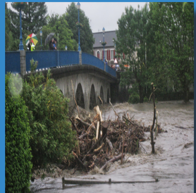
Embâcle sur le pont de Nay le 18 juin 2013
